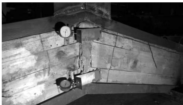
Рис.4. Сдвиг и образование трещин в узле перегиба.
